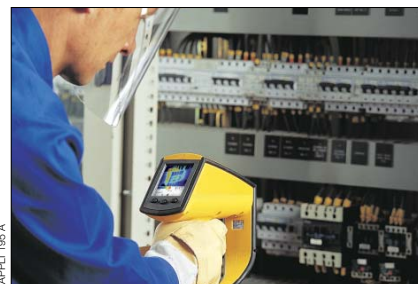
Контроль состояния электрораспределительных шкафов
