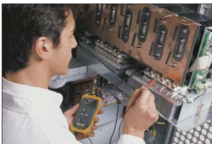
Проверка ИБП
