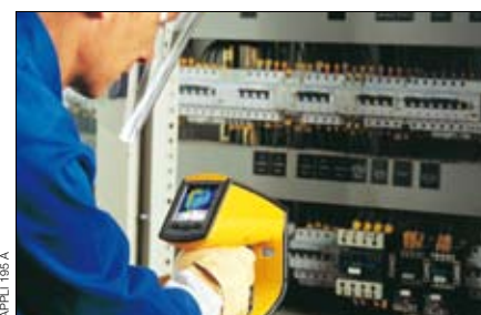
Контроль состояния электрораспределительных шкафов
